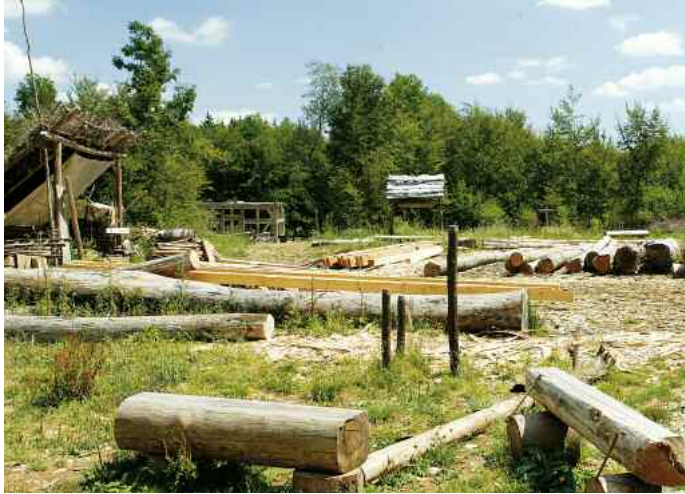
Liebe zum Detail: Aus dem Fachwerk (Hintergrund) wird das erste größere Gebäude werden – eine kleine Holzkirche. Der Plan für die Klosterstadt Campus Galli wurde vor 1200 Jahren gezeichnet.
