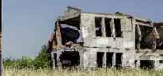
Zerbombter Haus – Spuren bis heute sichtbar.
